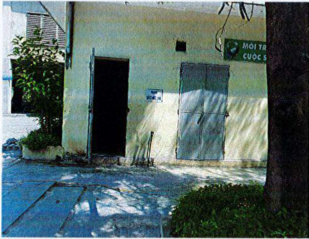
Hình PL 1: Trạm xử lý nước thải tập trung
