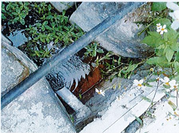
Hình 3: Rãnh thoát nước thải khu vực văn phòng điều hành Mỏ
