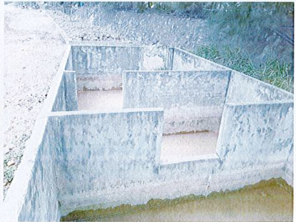
Hình 2: Hồ lắng nước thải công nghiệp Mỏ Núi Rùa
