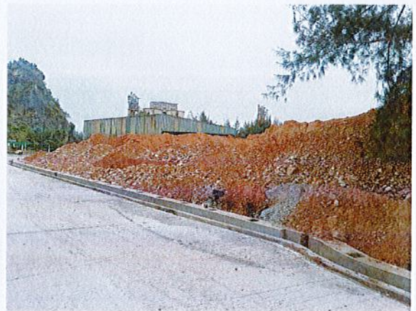
Hình 2: Rãnh thu gom nước mưa khu vực bãi chứa sét
