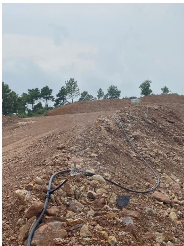
Hình 1: Hệ thống phun sương dập bụi
