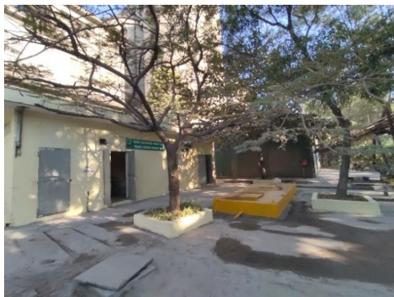
Hình 1: Trạm xử lý nước thải tập trung
